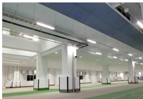
(下関漁港 本館南棟増築工事・電気設備工事)
